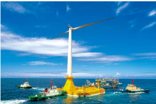
洋上風力発電施設の建設風景
